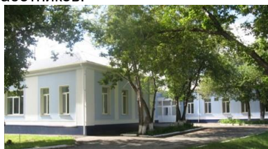
фото: Здание Ишимского медицинского колледжа по ул. К.Маркса
